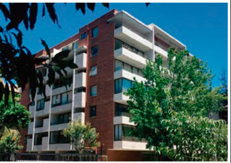
Edificio Marcel Duhaut 2755, Providencia Volumen de obra: 4.589m2 33 departamentos Año: 2015 Dir. de obras: Rodrigo Sanhueza Sanchez
