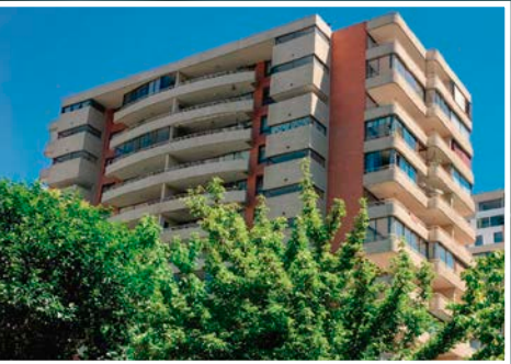
Edificio Fontana Rosa 7130, Las Condes Volumen de obra: 8.285m2 89 departamentos en 14 pisos Año: 2006 Director de obras: Rodrigo Sanhueza Silva
