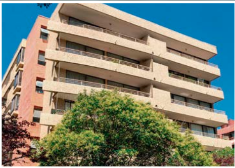
Edificio Los Crisantemos 764, Providencia Volumen de obra: 4.437m2 47 departamentos en 7 pisos Año: 2008 Director de obras: Rodrigo Sanhueza Silva
