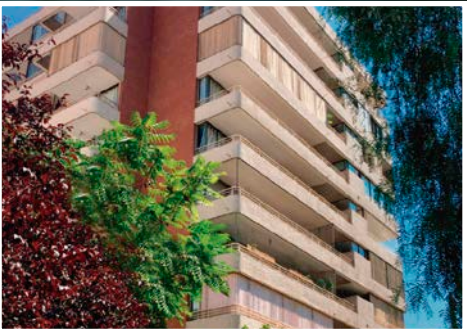
Edificio Quillay 2515, Providencia Volumen de obra: 4.332m2 38 departamentos en 11 pisos Año: 2003 Director de obras: Rodrigo Sanhueza Silva
