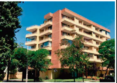
Edificio Luis Videla Herrera 2351, Prov. Volumen de obra: 3.580m2 31 departamentos en 7 pisos Año: 2012 Dir. de obras: Rodrigo Sanhueza Silva
